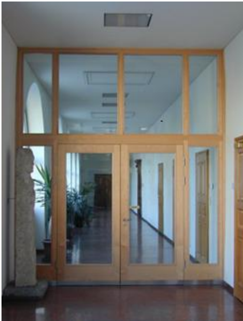
Slika 13: Požarna zasteklitev v kombinaciji z lesom
