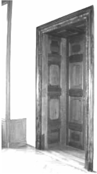
Slika 15: Primer lesenega požarnega podboja
