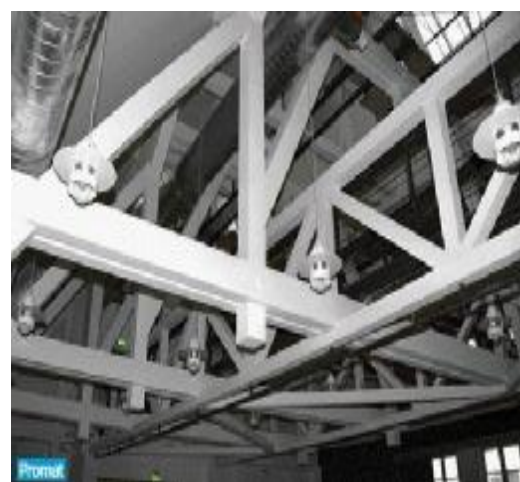
Slika 4: Požarna zaščita stropne konstrukcije (7,8) s požarnimi ploščami (2), ki so privijačene (6) v lesene nosilce in dodano izolacijo kamene volne (5), ki poleg toplotne in zvočne izolacije opravlja tudi funkcijo požarne zaščite.
