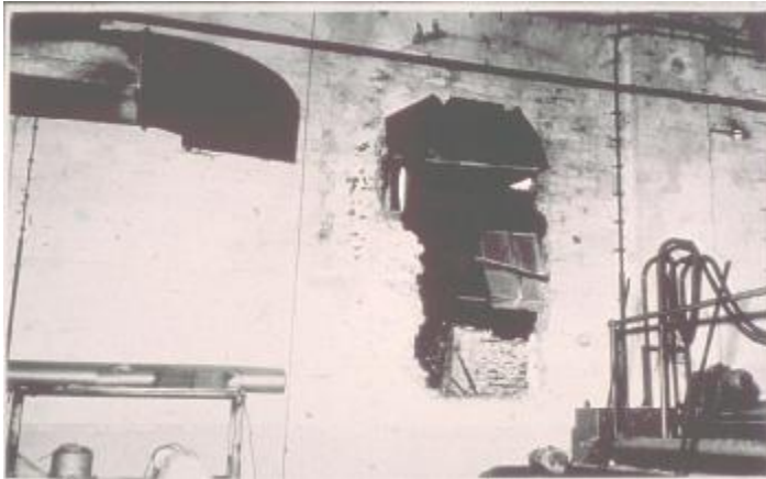
Slika 4: posledice raztezka pločevinastega kanala
