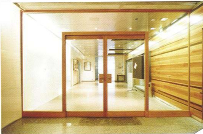
Sistemska konstrukcija z vertikalnimi silikonskimi regami
