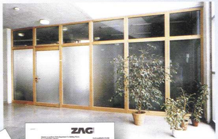
Sistemska konstrukcija z vertikalnimi in horizontalnimi silikonskimi regami
